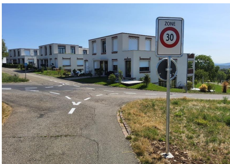
Abbildung 17: Beispiel Zoneneingang am Fahrbahnrand
