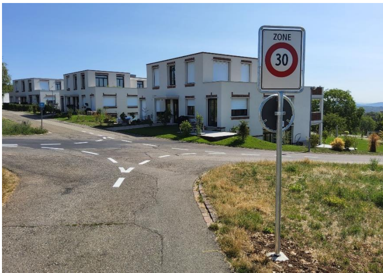
Abbildung 7: Beispiel Zoneneingang am Fahrbahnrand
