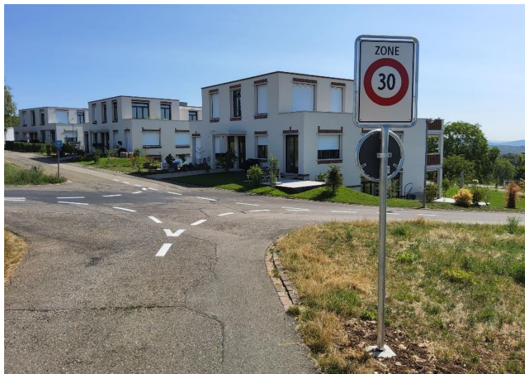
Abbildung 10: Beispiel Zoneneingang am Fahrbahnrand
