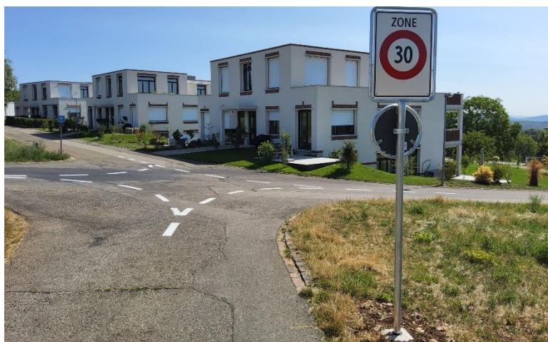
Abbildung 13: Beispiel Zoneneingang am Fahrbahnrand
