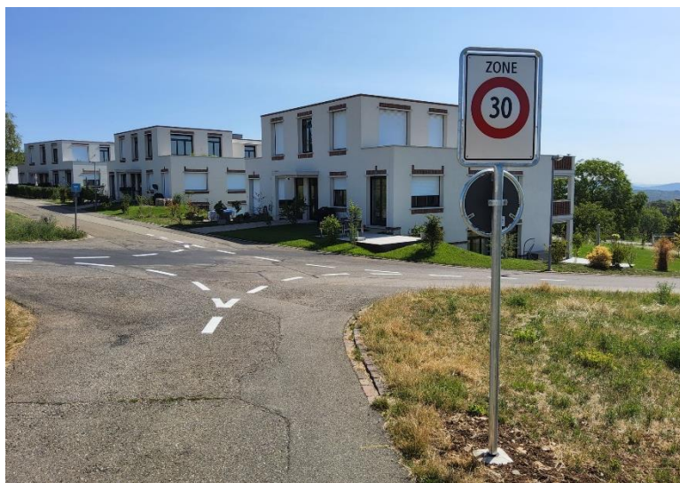
Abbildung 10: Beispiel Zoneneingang am Fahrbahnrand
