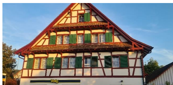
Bild: Das Küblerhaus mit den neu eingebauten Fenstern
